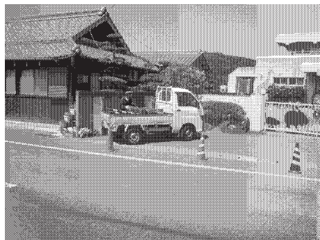
幼稚園前、10時頃バイロン設置中
